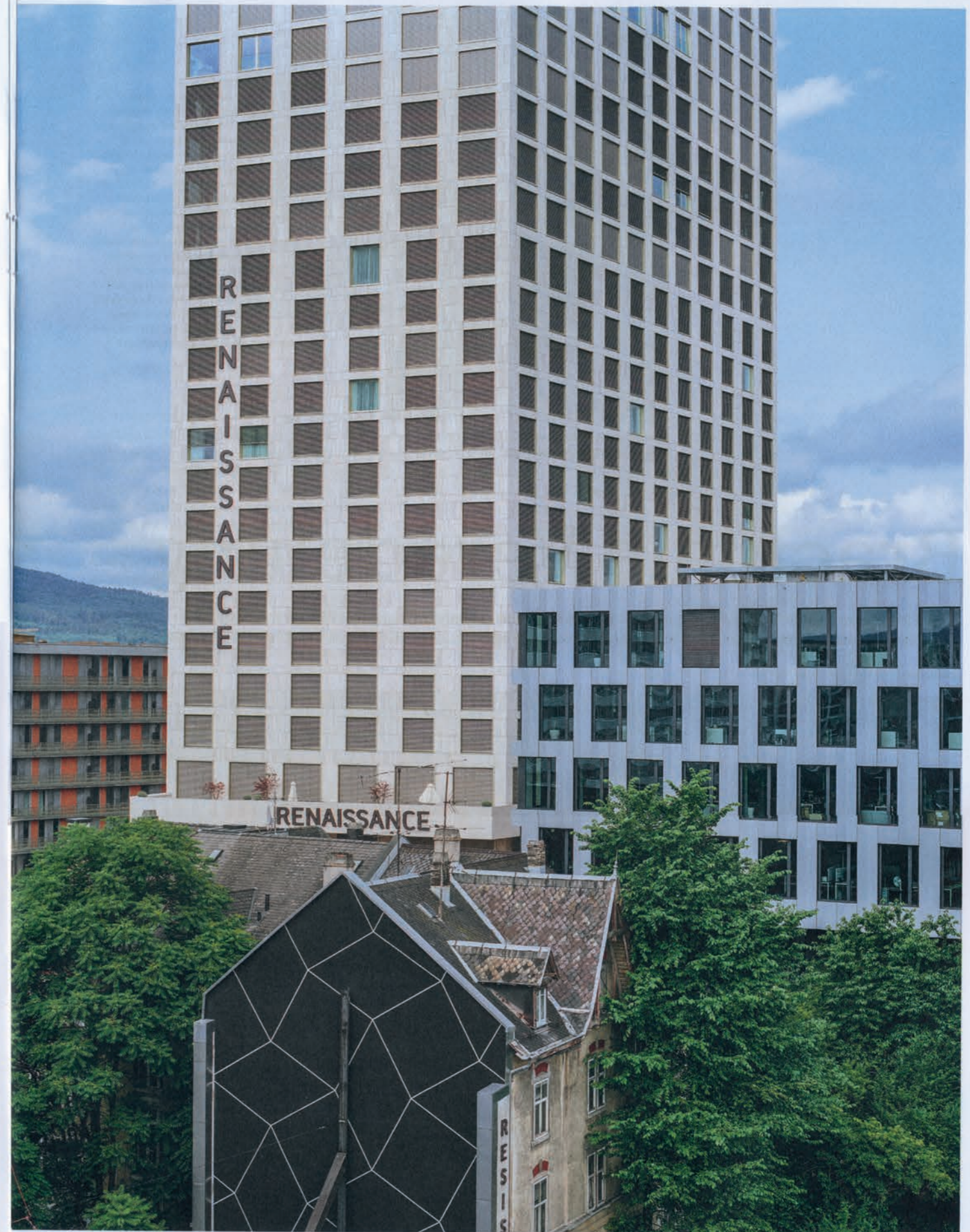
Die Machtverhältnisse sind klar und plakativ: Der Turm thront über dem Zürcher «Nagelhaus», das zugunsten einer neuen Zufahrt abgerissen werden soll.
